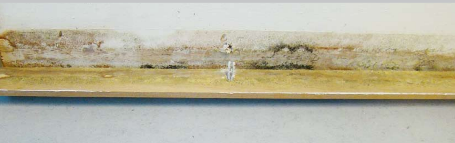
Schimmel hinter einer Fußleiste. Nicht immer ist die Ursache für einen Geruch so leicht zu ermitteln
