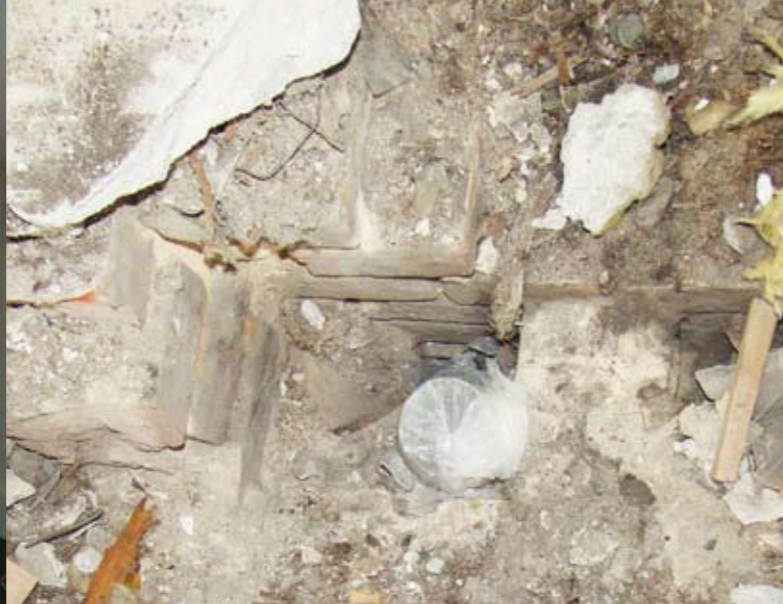
Wohnung in Dachgeschoss. Ein muffiger Geruch durch ein offen liegendes Stangenlüftungsrohr war lange Zeit über mit einem Duftspray überdeckt worden
