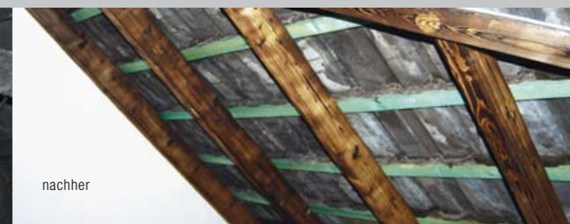
Trockeneisstrahlverfahren nach einem Brand: Reinigung des Dachbodens mit gefrorenem Kohlenstoffdioxid (CO 2 )
