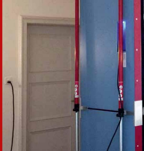
An der Wand des Badezimmers werden ein Eckpanel und ein kleines Wandpanel aufgestellt, um von der den Fliesen abgewandten Wandseite aus eine schnelle und effektive Trocknung zu gewährleisten. Auch hier wurde die Tapete vorher von der Wand abgelöst. Im betroffenen Kellerraum werden ebenfalls zwei Panels an der Wand sowie je ein Eckpanel im Wand-/Deckenbereich und im Sockelbereich aufgestellt.
