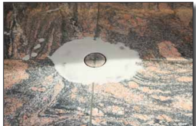
Zwischenergebnis: Die CERAVOGUE Bohrung mit einem minimalen „Schmutzanfall“ und einer geringen Menge an „Bohrwasser“.
