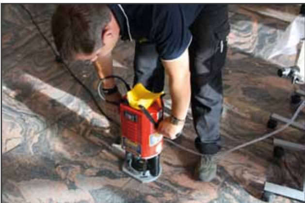
Einrichten des Werkzeuges. Spezialbohrmaschine nur zur Oberflächenbohrung.
