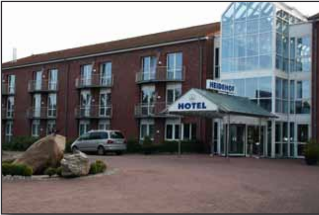
Konferenzräume im Erdgeschoß Maßnahme: Estrichdämmschicht Trocknung auf Abdichtung mit Fußbodenheizung
