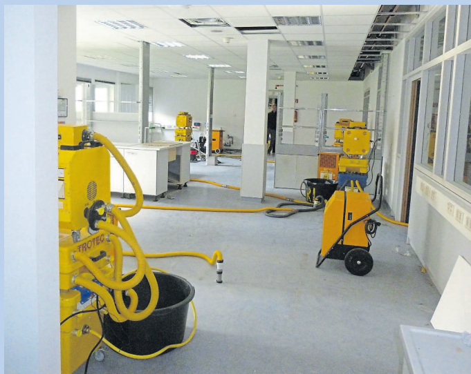
Durch gezielte Bautrocknung wird Zeit gespart und gleichzeitig Folgeschäden durch Restfeuchte vermieden.
