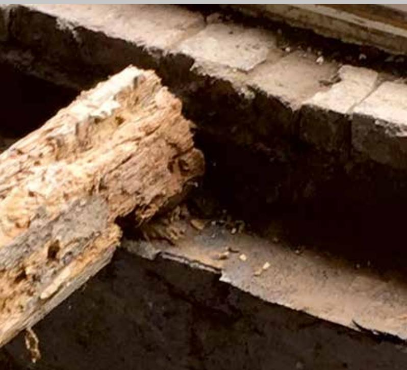
Durch die veränderte Holzstruktur kann es zum Verlust der Stabilität und Tragfähigkeit von verbauten Hölzern kommen. Die Folge ist Einsturzgefahr beispielsweise bei befallenen Dachkonstruktionen oder auch Dielenbrettern.
