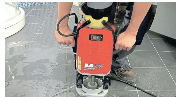
Zur Trocknungsvorbereitung werden gezielt kleine Bohrlöcher gesetzt.
