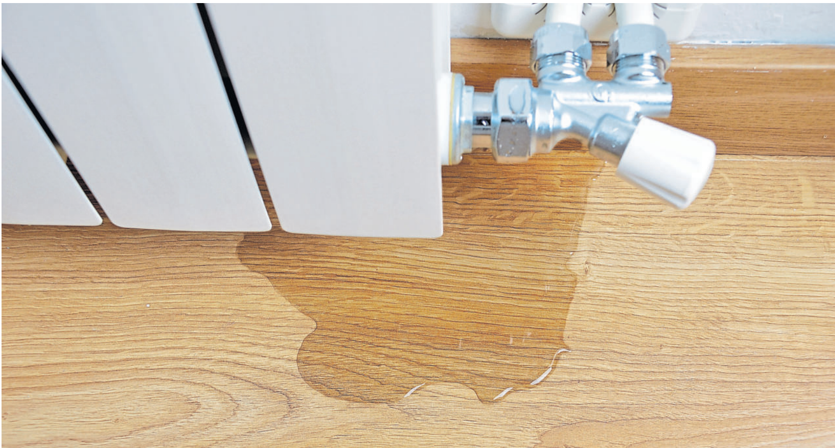
Wenn Wasser nicht sofort entfernt wird, kann es neben Schäden am Holzboden auch zu Schimmel- und Pilzwachstum kommen.
